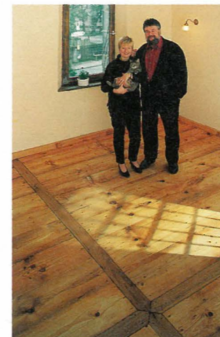
Viola und Wolfgang Riedelbauch auf Ihrem frisch restaurierten Boden (Bretter raus, alte Isolierung raus, Bretter herrichten, Isofloc rein, Bretter rein, Ölen, schon fertig!)
