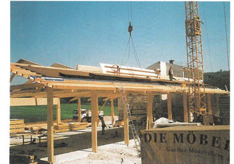
5x2 Meter groß sind die 3-Schichtplatten, aus denen alle Innenwände und Decken gefertigt sind. Die Wände haben wir weiß gestrichen um dem Holzinfarkt vorzubeugen.
